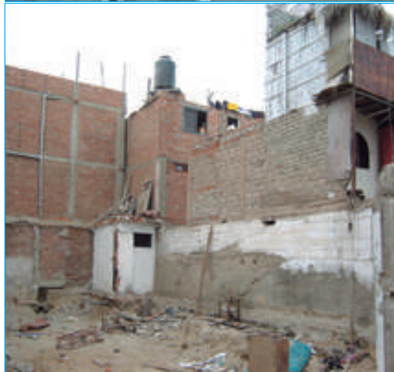
Figura 12. Viviendas con cargas inestables en el nivel superior en la Urb. Santa Cruz y algunas de ellas no cuentan con columnas y la loza aligerada no tiene el espesor adecuado según las normas de edificaciones.
