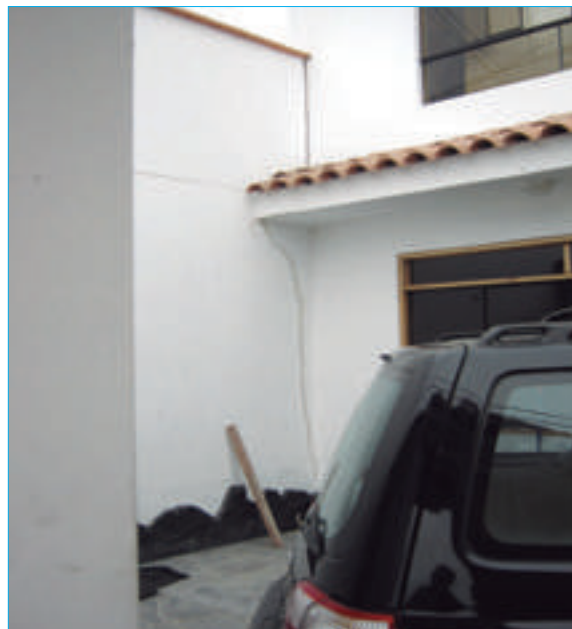
Figura 8. Una de las viviendas de la Mz. J de la Urb. La Planicie que tiene rajaduras en los muros porque la fachada está cediendo hacia la calle como consecuencia de los silos.
