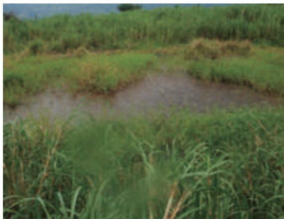
Foto 10. Mamante de agua, ubicada en la parte alta de la ladera sur este del cerro La Laguna, condición desfavorable para la estabilidad del terreno.
