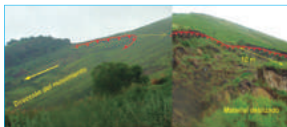
Foto 4. Deslizamiento traslacional, obsérvese la separación entre el escarpe principal y el material deslizado.
