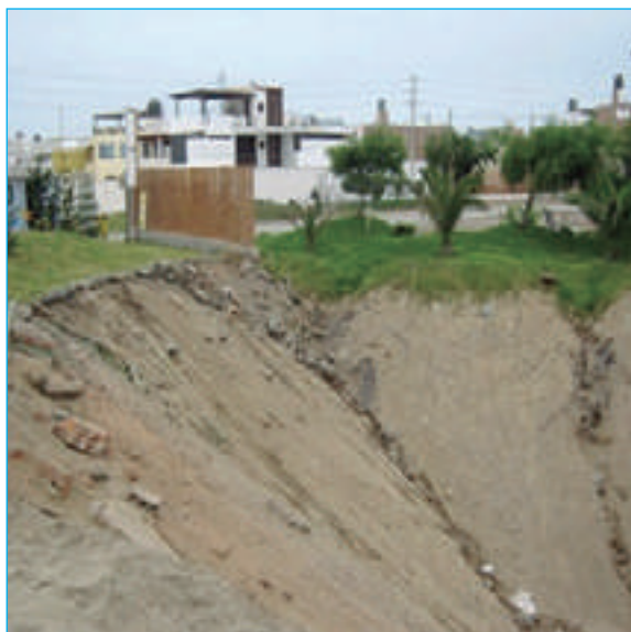
Figura 14. Quebrada de la Planicie que fue bloqueado el cauce por la construcción de la garita de control y vaciado de concreto para el estacionamiento de vehículos.
