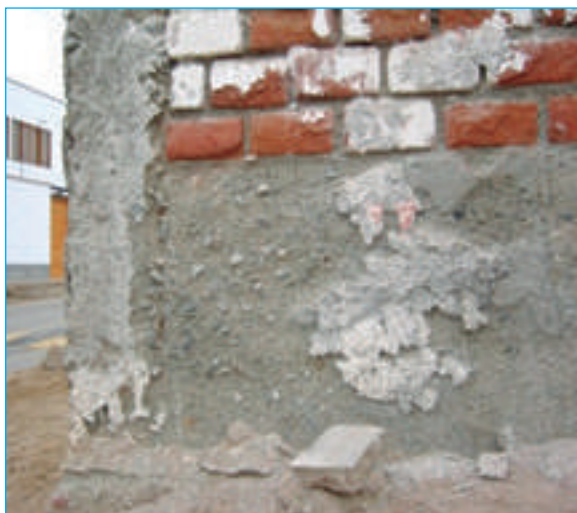
Figura 15. La humedad es uno de los factores que va deteriorando las viviendas.
