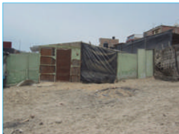
Figura 7. Vivienda de madera ubicada en la Asoc. de Viv. Costa Azul zona A.
