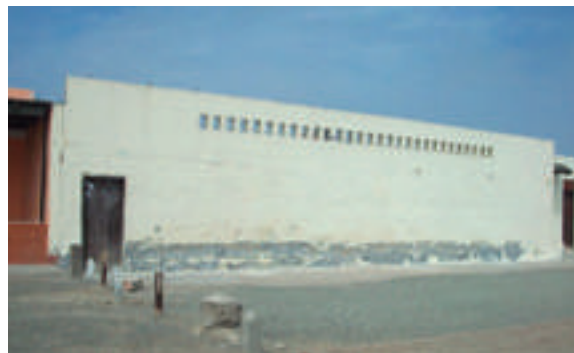
Figura 5. Vivienda ubicada en el malecón de Punta Negra zona norte.
