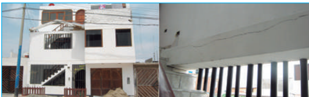
Figura 3. La imagen del lado izquierdo muestra una vivienda de la Urb. Santa Cruz sin mayor daño aparente, pero al ingresar se observa daño estructural en vigas y columnas (imagen derecha).
