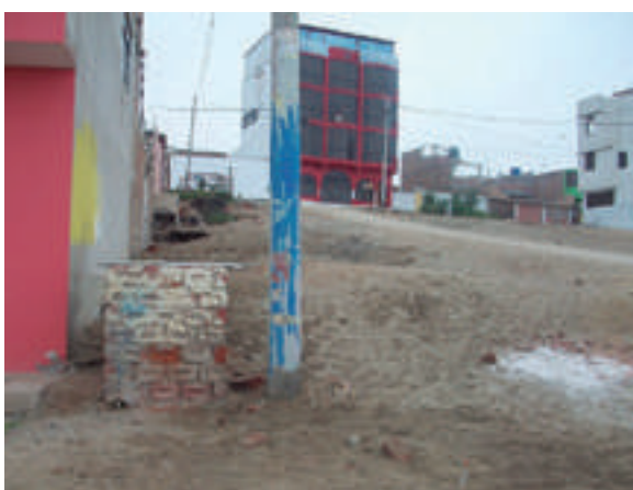
Figura 4. Vivienda de 5 pisos ubicada en pendiente muy fuerte (50% de pendiente).
