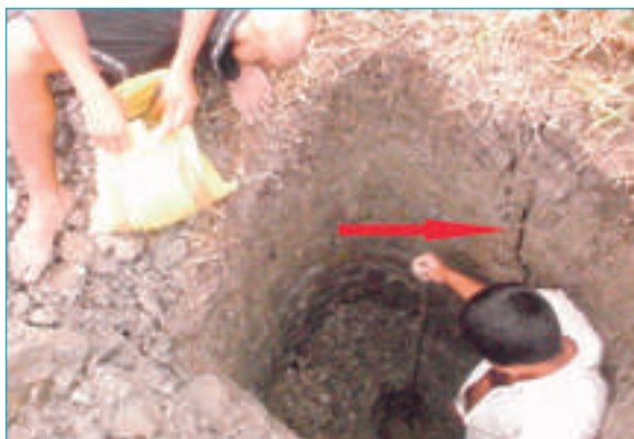
Foto 7. La flecha de color rojo muestra una grieta de desecación, de 3 cm de abertura, ubicada en la parte frontal de la laguna Azul.
