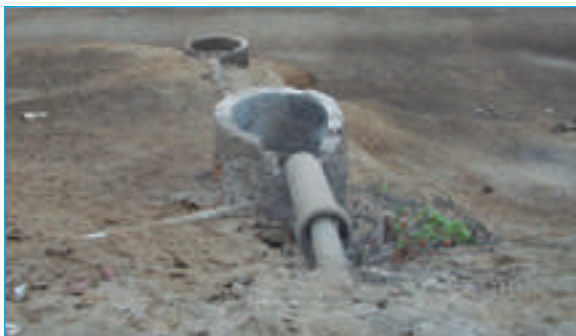
Figura 9. Malas instalaciones de desagüe en la urbanización La Merced.
