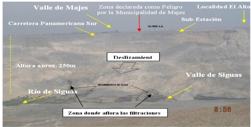
Figura 5. Vista del deslizamiento registrado desde el 2004 en el margen derecho aguas abajo del río Sigüas, donde se señala la zona donde aparecen las filtraciones, así como los lugares susceptibles a ser perjudicados.
