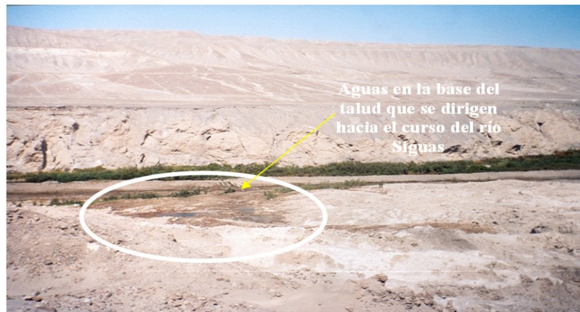
Figura 9. Agua producto de las filtraciones que se dirigen al curso del río Sigwas, valle de Sigwas.
