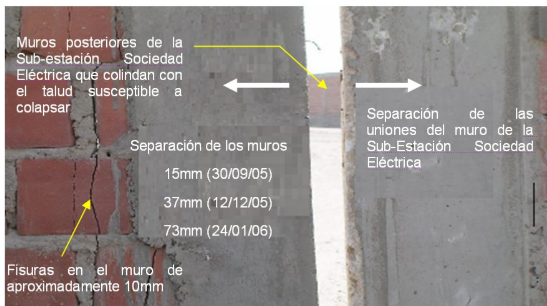
Figura. 7. Separación de las uniones de una parte del muro de la Sub-Estación Sociedad Eléctrica SEAL que se encuentra en la Zona de Peligro demarcado por la Municipalidad de Majes debido al proceso continuo del deslizamiento registrado desde el 2004.
