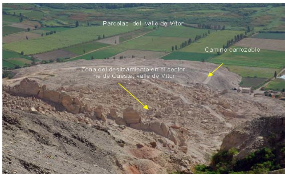
Figura 13. Deslizamiento en el sector Pie de Cuesta, valle de Vitor (Flores N. y Maggiolo P. 1975).
