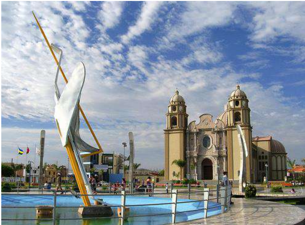
Figura 1: Plaza de Armas de la Ciudad de Nuevo Chimbote
