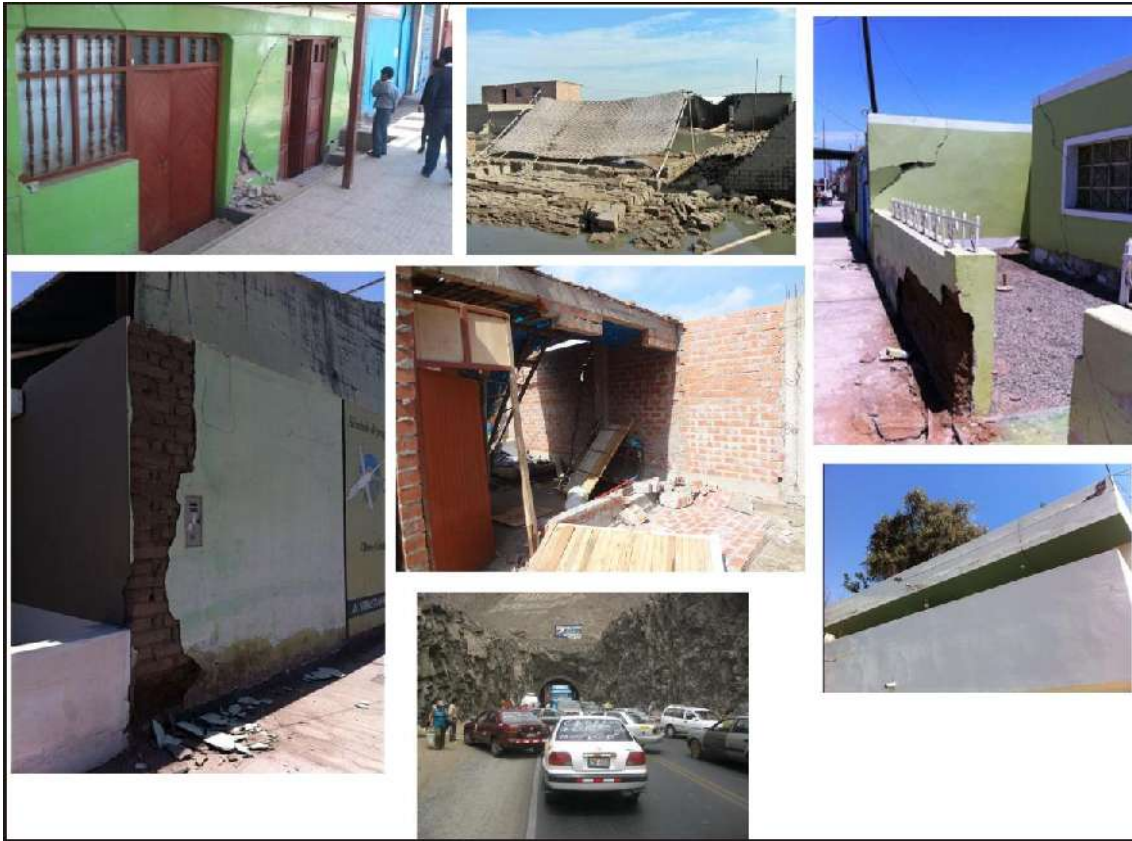
Figura 11: Imágenes de daños observados en las ciudades de Acarí, Bella Unión, Yauca y Chala debidos al sismo del 25 de setiembre de 2013.
