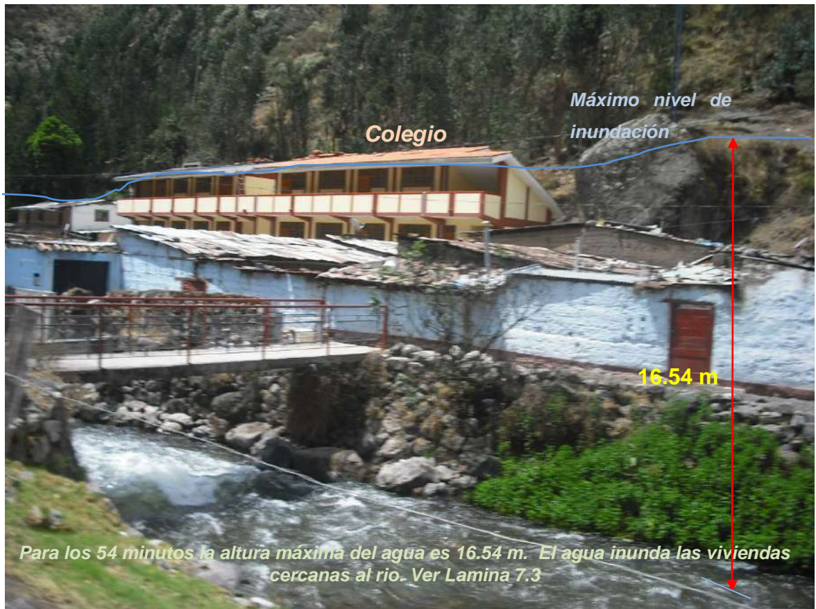
Figura 7-25: Colegio inundado a los 54 minutos de generada la rotura de presa.
