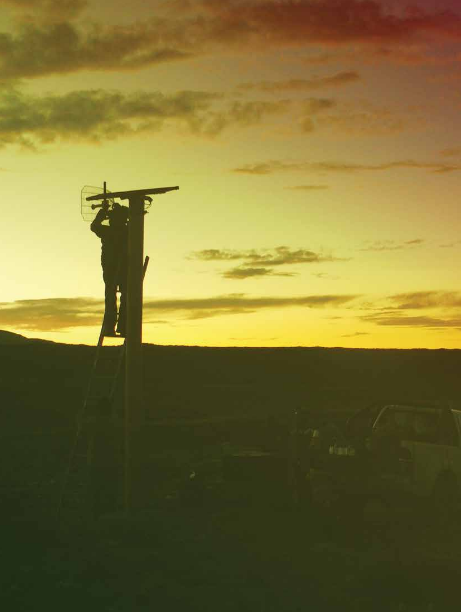
Estación sísmica de Cajamarca (CAJ), ubicado en el volcán Sabancaya.
