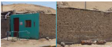
Figura 3.8: Edificación construida de adobe con más de 50 años de antigüedad. Se encuentra dentro de la zona de inundación y presenta deterioro y/o humedad en sus paredes. La vulnerabilidad física identificada para este predio es alta. Sin embargo, también es altamente vulnerable por exposición ante eventos de tsunami.
