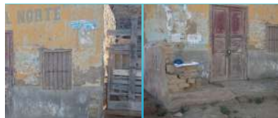
Figura 3.7: Edificación construida de adobe con más de 50 años de antigüedad. Posee deterioro y/o humedad en la parte frontal y en las paredes del inmueble y tiene un techo inestable. Se identificó que su vulnerabilidad es alta ante eventos de tsunami.
