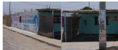
Figura 3.5: inmueble construido de adobe ubicado en Av. Puerto Grande. Este inmueble posee más de 50 años de antigüedad y se identificó con regular estado y con techo inestable de caña. Asimismo, se encuentra dentro del potencial área de inundación por eventos de tsunami de origen cercano según las cartas de inundación del IGP y la DHN.
