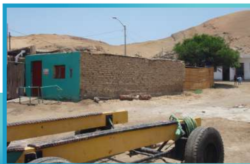
Figura 3.8: Edificación construida de adobe con más de 50 años de antigüedad. Se encuentra dentro de la zona de inundación y presenta deterioro y/o humedad en sus paredes. La vulnerabilidad física identificada para este predio es alta. Sin embargo, también es altamente vulnerable por exposición ante eventos de tsunami.
