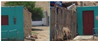
Figura 3.8: Edificación construida de adobe con más de 50 años de antigüedad. Se encuentra dentro de la zona de inundación y presenta deterioro y/o humedad en sus paredes. La vulnerabilidad física identificada para este predio es alta. Sin embargo, también es altamente vulnerable por exposición ante eventos de tsunami.
