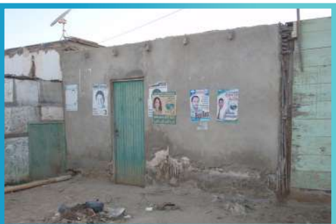
Figura 3.9: Edificación con más de 60 años de antigüedad y presentan muros de quincha deteriorados, donde se observan grietas, rajaduras y pérdida de recubrimiento de los muros en la parte frontal. Es necesario realizar una evaluación y refacción de la edificación por su estado actual.
