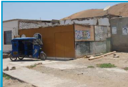
Figura 3.6: Inmueble expuesto ante eventos de tsunami, ubicado en la localidad de Puerto Huarney. Posee cobertura de techo de esteras y madera y las características físicas identificadas en su evaluación lo hacen altamente vulnerable ante eventos de tsunami.
