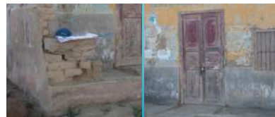
Figura 3.7: Edificación construida de adobe con más de 50 años de antigüedad. Posee deterioro y/o humedad en la parte frontal y en las paredes del inmueble y tiene un techo inestable. Se identificó que su vulnerabilidad es alta ante eventos de tsunami.
