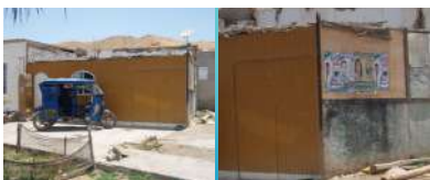
Figura 3.6: Inmueble expuesto ante eventos de tsunami, ubicado en la localidad de Puerto Huarney. Posee cobertura de techo de esteras y madera y las características físicas identificadas en su evaluación lo hacen altamente vulnerable ante eventos de tsunami.
