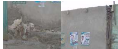
Figura 3.9: Edificación con más de 60 años de antigüedad y presentan muros de quincha deteriorados, donde se observan grietas, rajaduras y pérdida de recubrimiento de los muros en la parte frontal. Es necesario realizar una evaluación y refacción de la edificación por su estado actual.
