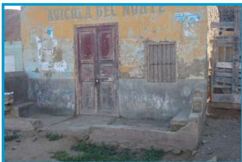
Figura 3.7: Edificación construida de adobe con más de 50 años de antigüedad. Posee deterioro y/o humedad en la parte frontal y en las paredes del inmueble y tiene un techo inestable. Se identificó que su vulnerabilidad es alta ante eventos de tsunami.
