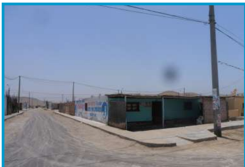
Figura 3.5: inmueble construido de adobe ubicado en Av. Puerto Grande. Este inmueble posee más de 50 años de antigüedad y se identificó con regular estado y con techo inestable de caña. Asimismo, se encuentra dentro del potencial área de inundación por eventos de tsunami de origen cercano según las cartas de inundación del IGP y la DHN.
