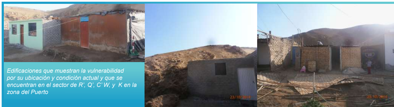
Figura 3.15: Vista de las edificaciones vulnerables por su ubicación y condición actual de la edificaciones en la localidad de Puerto Huarmey.
