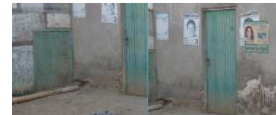
Figura 3.9: Edificación con más de 60 años de antigüedad y presentan muros de quincha deteriorados, donde se observan grietas, rajaduras y pérdida de recubrimiento de los muros en la parte frontal. Es necesario realizar una evaluación y refacción de la edificación por su estado actual.
