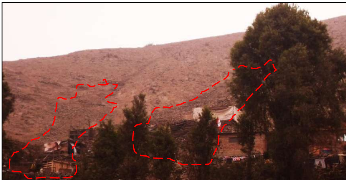
Figura 19: Las líneas segmentadas de color rojo nos muestran caída de rocas de 7” en los alrededores de la Zona el Lúcumo.
