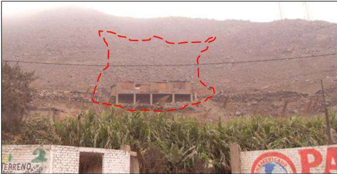
Figura 19: La línea segmentada de color rojo muestran caídas de rocas en el extremo noreste del frontis de la planta de Sedapal
