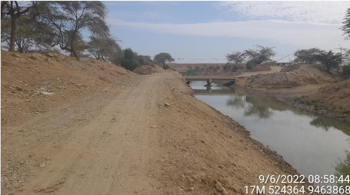
*Figura 6.- Depósito fluvial a lo largo del canal Miguel Checa en cuyo fondo del cauce se sitúa materiales heterogéneos, principalmente arenas y limos.*
