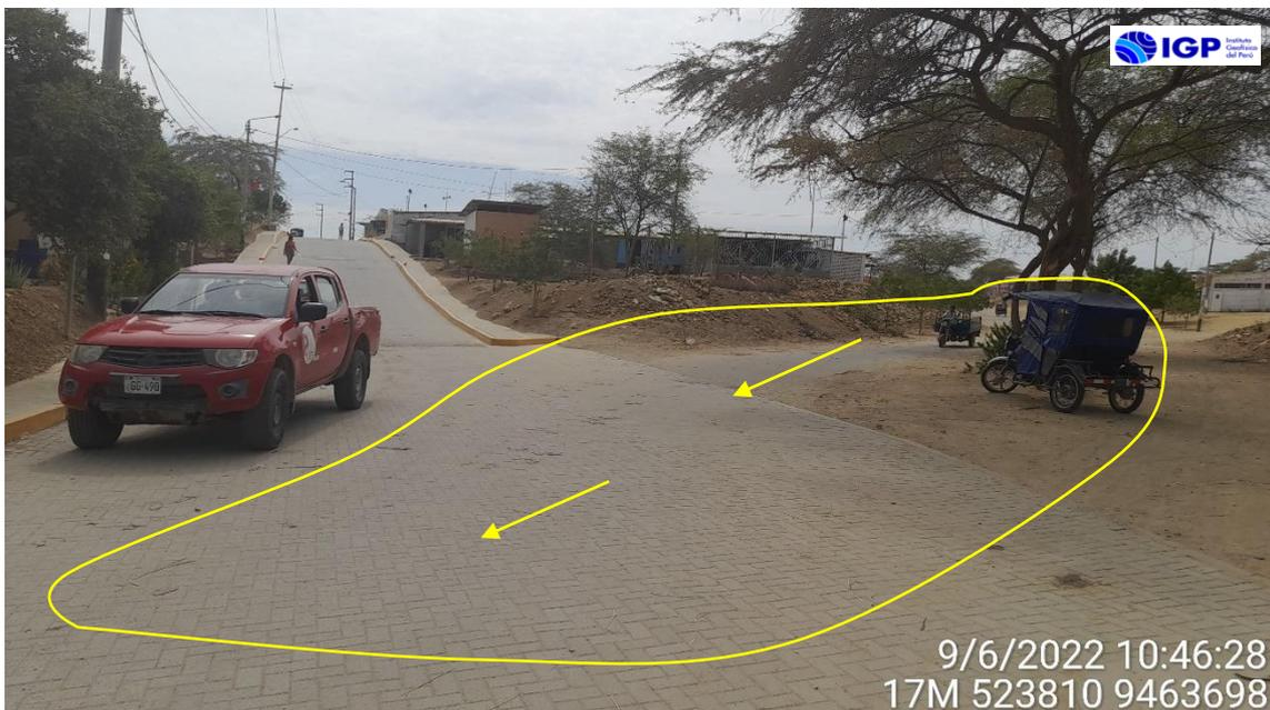
Figura 17. Inundaciones pluviales (polígono amarillo) que se producen en la vía de ingreso hacia el C.P. La Golondrina, cuyas aguas de escorrentía provienen desde el Barrio Señor Cautivo, atravesando acceso conformado por bloquetas.
