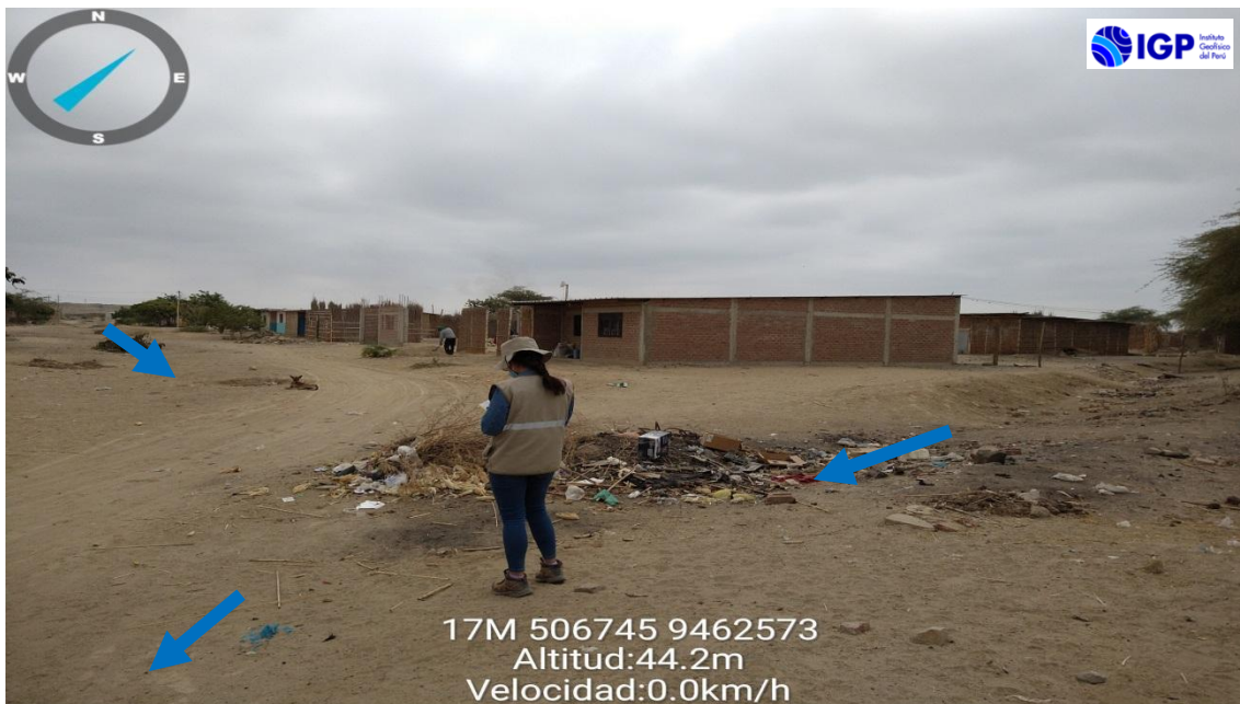
Figura 14. Zona de confluencia de escorrentías superficiales, generándose inundaciones pluviales que afectan las viviendas aledañas
