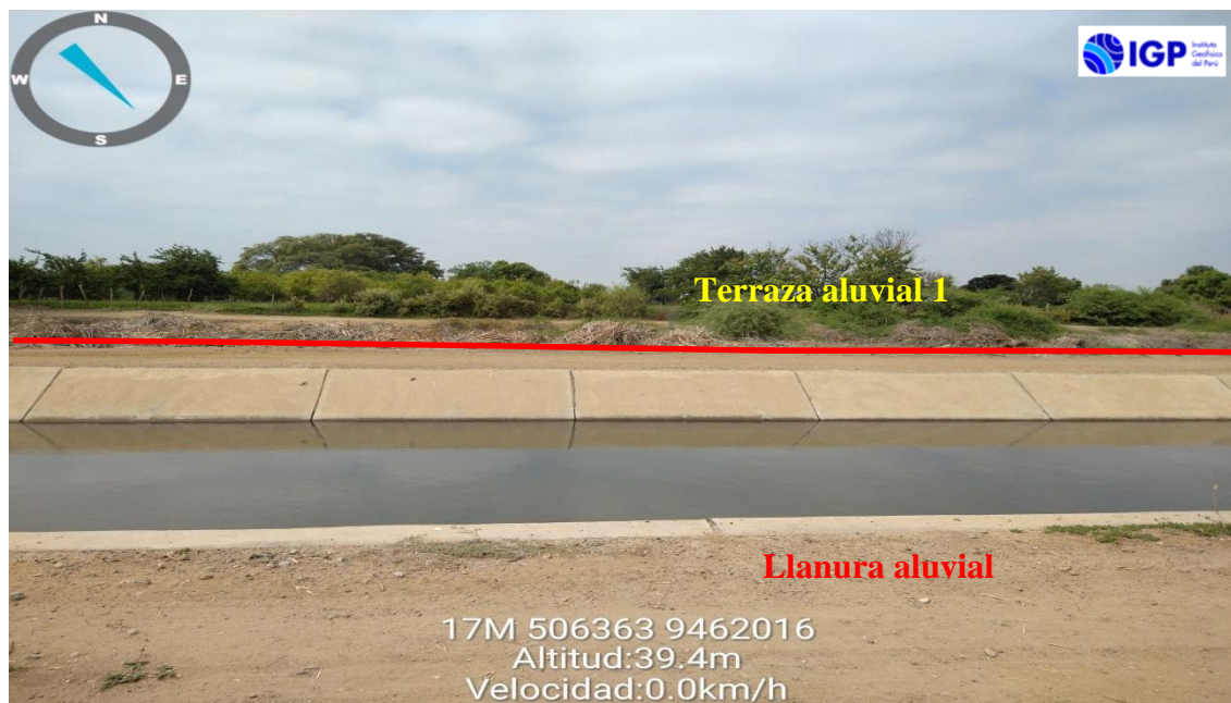
Figura 8.- Límite (línea roja) entre la terraza aluvial 1 y la llanura aluvial y sobre la última geoforma se asienta al área urbana del C.P. Monte Lima
