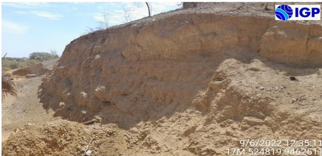
Figura 2. Areniscas y limoarcillitas sobre lomas situadas en el extremo occidental de las viviendas del C.P. Mallares.
