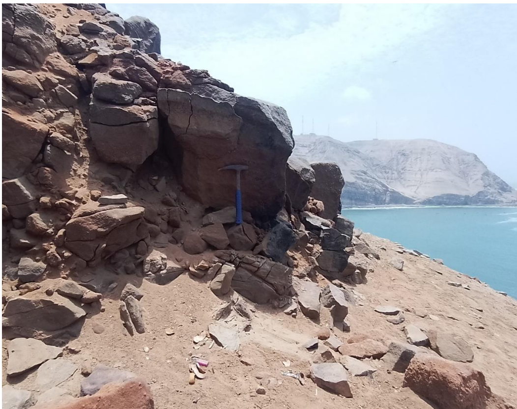
Figura 12.- Punto crítico bloques suspendidos en la parte alta del Morro Solar. Referencia punto 7 de Tabla 1.
