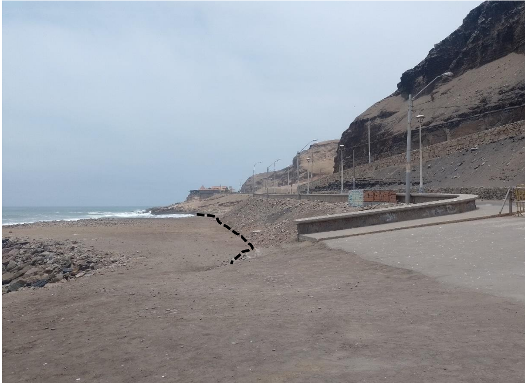
Figura 14- Zona de antigua acumulación de material antrópico, se observa un área plana colindante a la playa La Herradura y otra en forma de dique hacia la vía de salida boulevard Herradura, delimitada por la línea punteada color negro.
