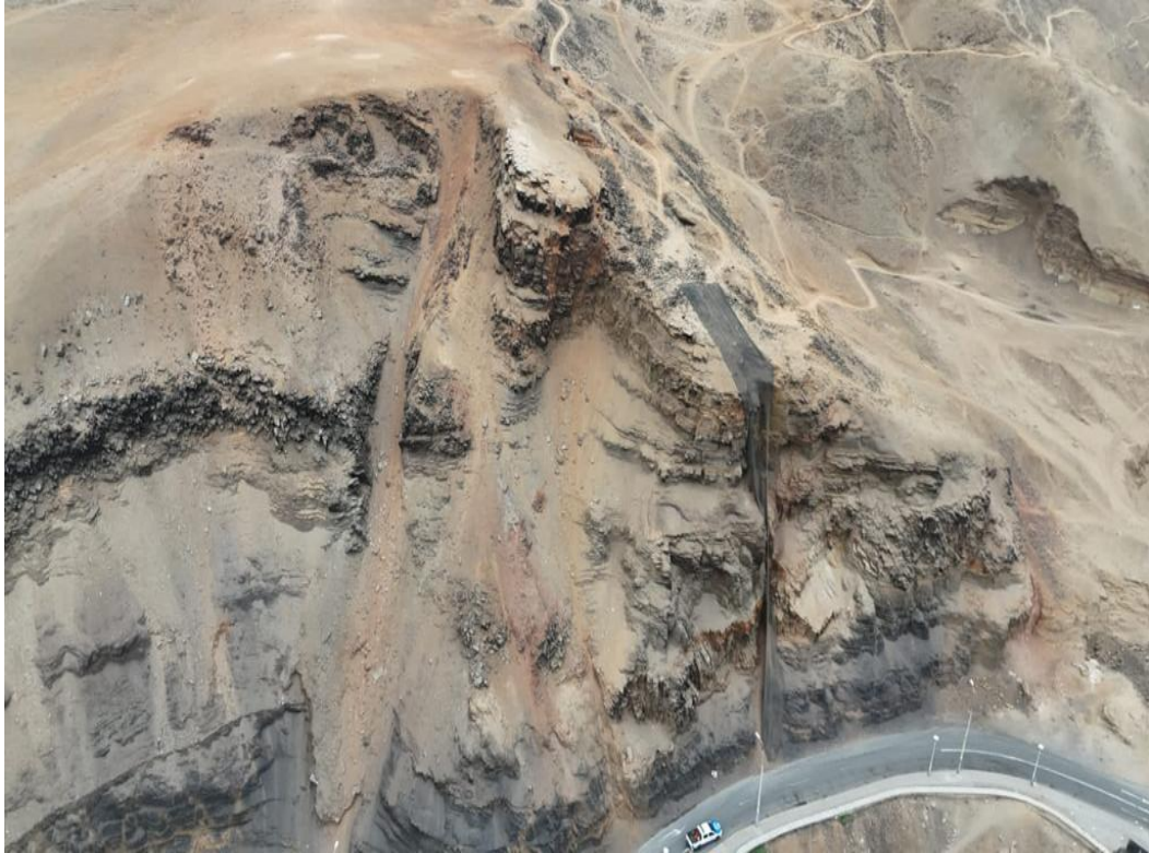
Figura 11.- Caída de rocas, estrato rocoso meteorizado y fracturado situado en la salida boulevard Herradura, Fuente: Municipalidad distrital de Chorrillos.
