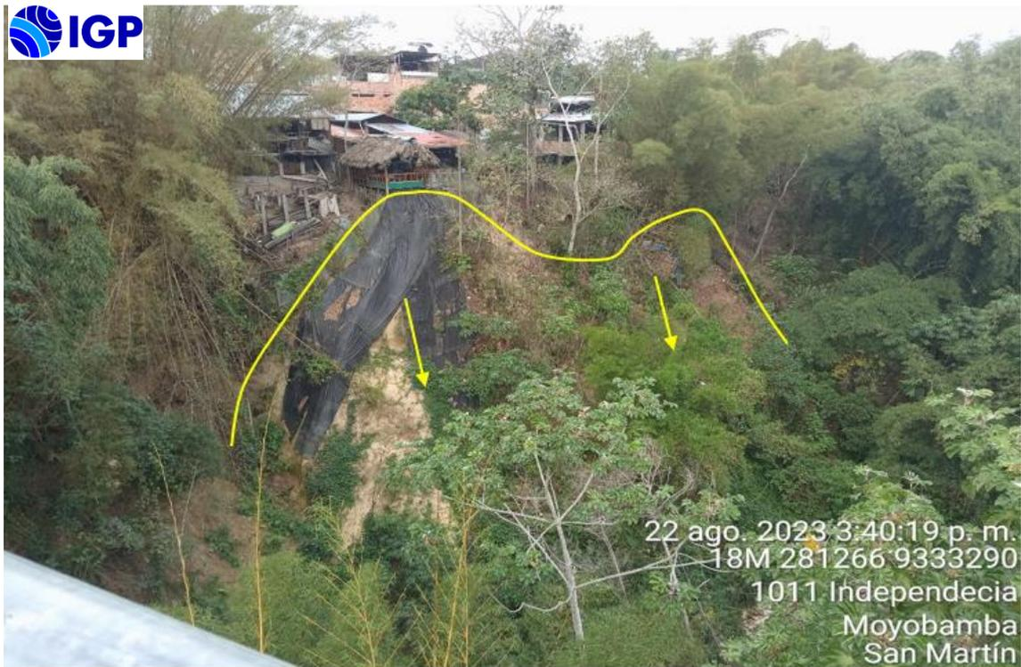
Figura 21. ...Continuación.../. c) Viviendas asentadas en taludes de la quebrada Coccocho que vienen siendo afectados por derrumbes (línea amarilla) visualizadas desde el puente colgante Coccocho.
