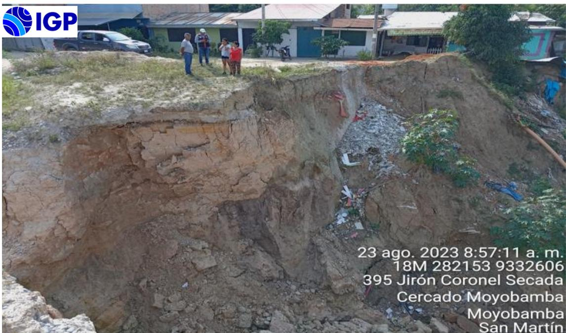
Figura 21. ...Continuación.../. d) Derrumbe en la cabecera de la quebrada Tumino (sector Villa Pedro Orbe) debido a la evacuación de aguas servidas de la zona desde hace 4 años por deficiencia de sistema de saneamiento, generando la erosión del cauce y derrumbes en taludes aledaños que podrían afectar viviendas aledañas.
