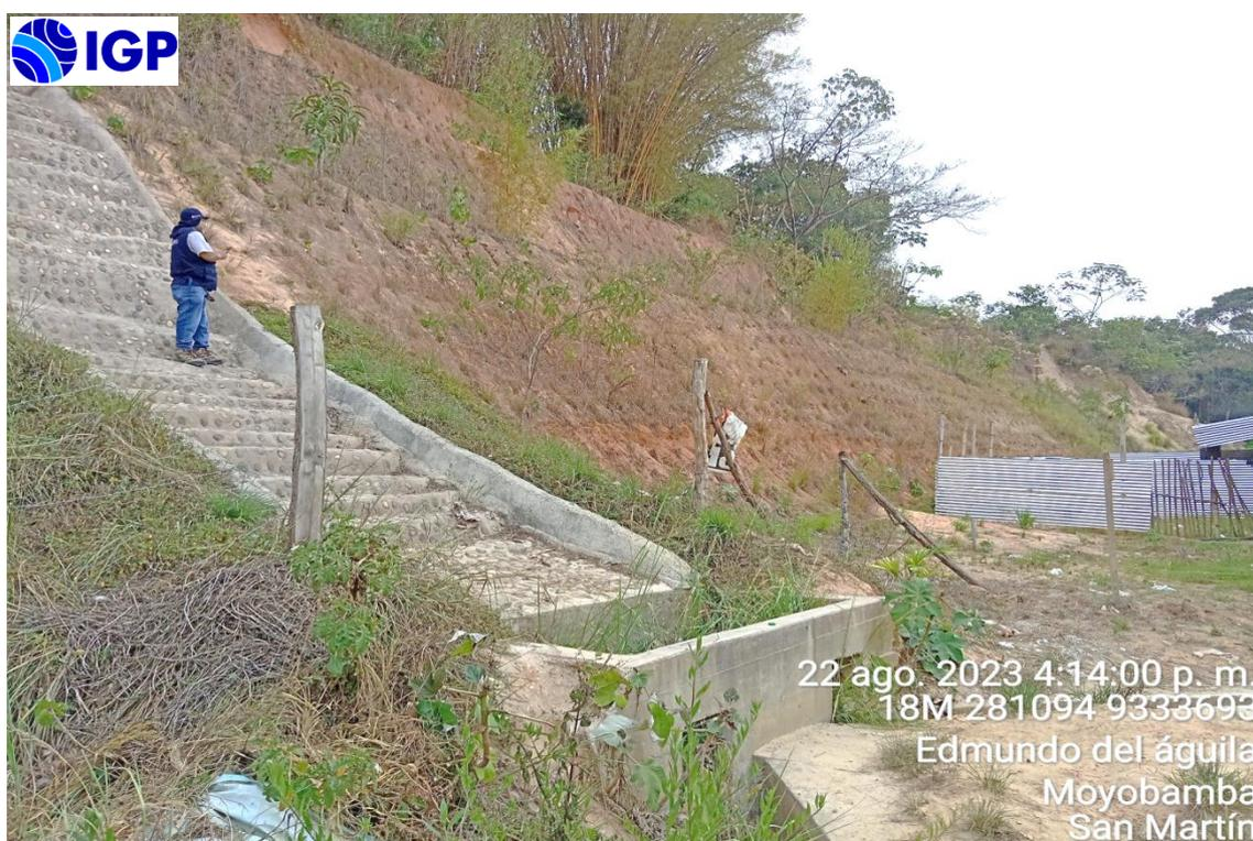
Figura 14. Acantilado situado en parte posterior del condominio El Mirador Rosillo donde la geoforma ha sido modificada con la finalidad de brindar estabilidad a los taludes.
