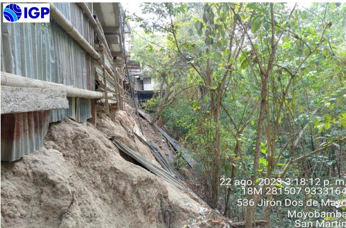
Figura 21. ...Continuación.../. b) Viviendas asentadas en taludes de quebrada Cococho que vienen siendo afectados por derrumbes durante el periodo de lluvias.
