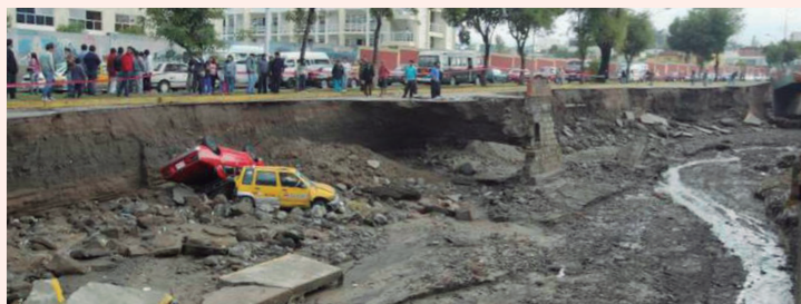
Daños generados por el descenso de un lahar secundario por la quebrada Venezuela, Arequipa.
