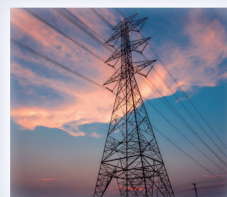
Daños en las plantas de electricidad
