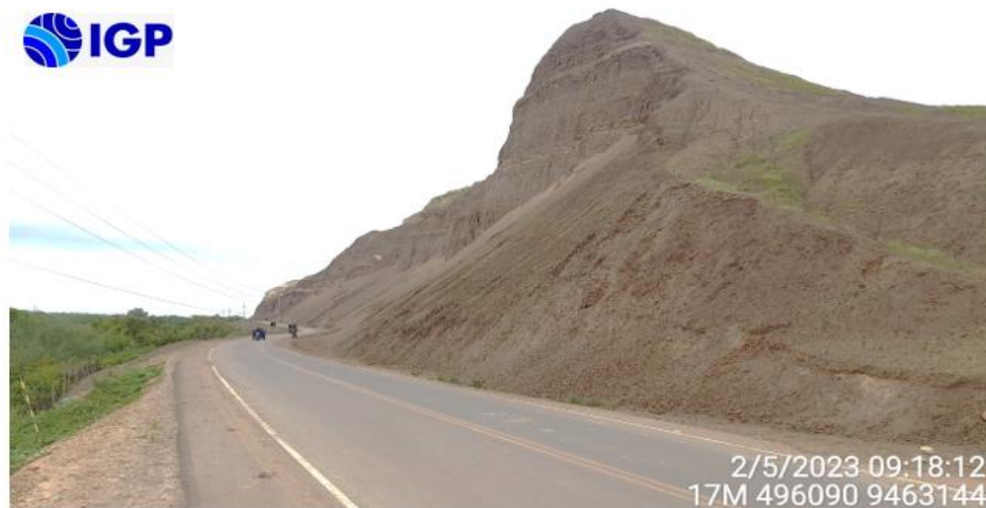
Figura 8.- Elevación del tipo loma ubicada al costado de la vía costanera que conforma el cerro denominado Cinchado
