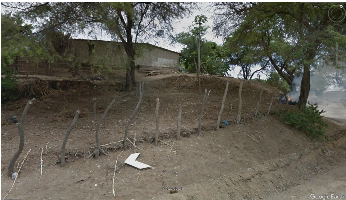
Figura 47.- Depósito aluvial antiguo conformado por materiales heterogéneos (gravas, arenas y limos) sobre el que se asientan las viviendas de Miramar
