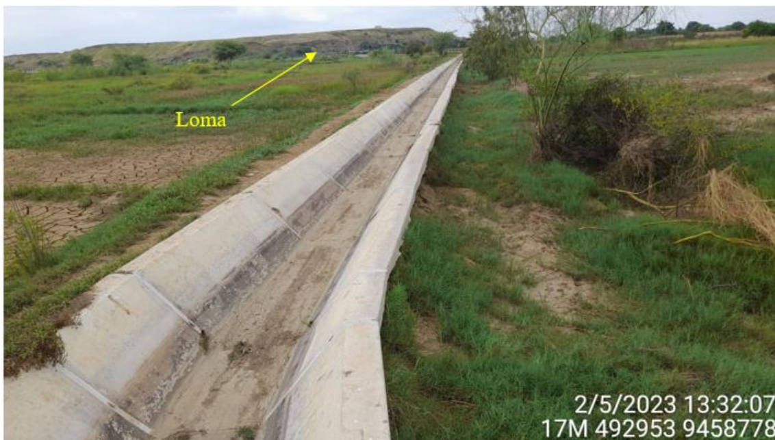
Figura 24.- Lomas ubicadas contiguas al canal Los Valencias
