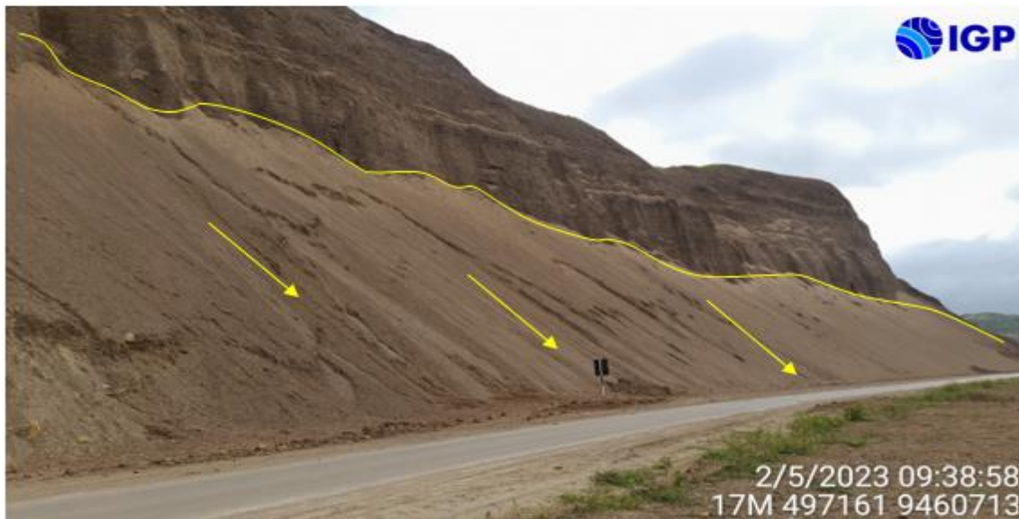
Figura 7.- Unidad geomorfológica vertiente coluvio – deluvial que resultó de la acumulación de materiales en la parte baja y media de la ladera
