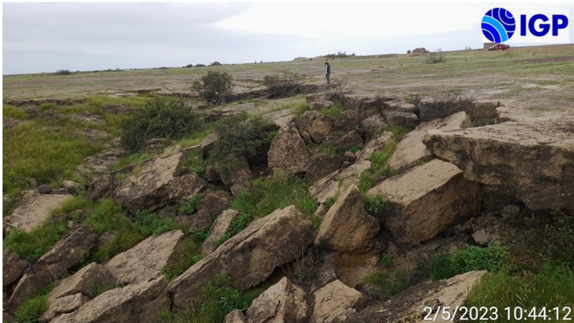
Figura 39.- Rocas areniscas de la Formación Chira que se presentan fracturadas en las inmediaciones de los taludes del sector Tablazo del C.P. San Felipe y susceptibles a desprendimientos
