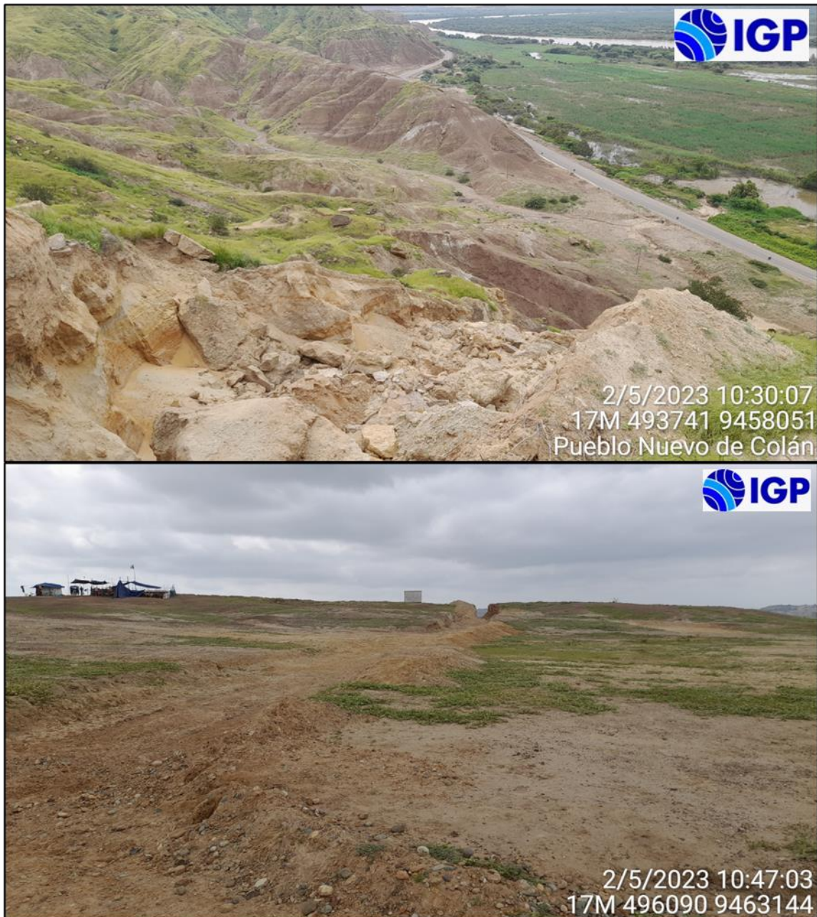
Figura 16.- La imagen superior muestra las laderas de la unidad geomorfológica loma que se ubica contigua a la vía Costanera (extremo norte), la imagen inferior muestra la cima de la loma denominada sector Tablazo del C.P. San Felipe donde se tiene previsto el reasentamiento de los habitantes del C.P. San Felipe, debido a que son afectados por flujos de lodos y detritos durante la ocurrencia de lluvias intensas
