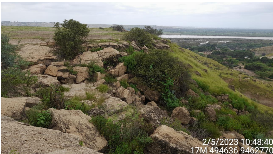
Figura 62.- Rocas sueltas susceptibles a caída de rocas en la cabecera de la quebrada Paredones
