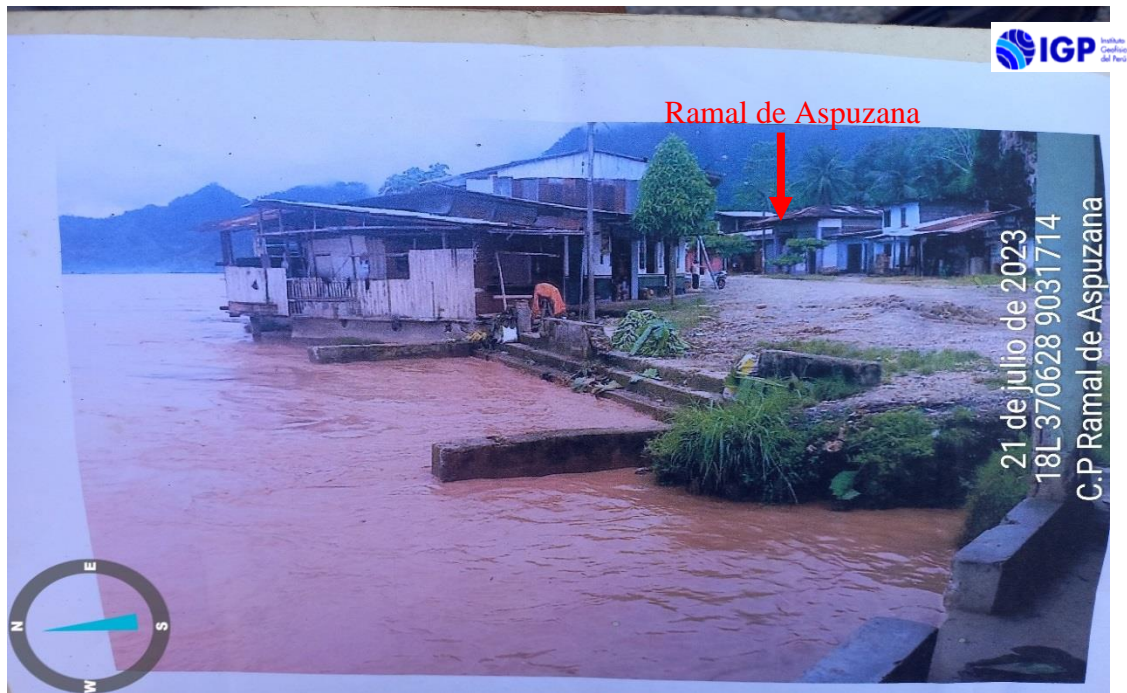
Figura 18.- Fotografía entregada por los pobladores, como evidencia de la inundación fluvial generada por el desborde del río Huallaga, afectando viviendas y áreas agrícolas en la zona
