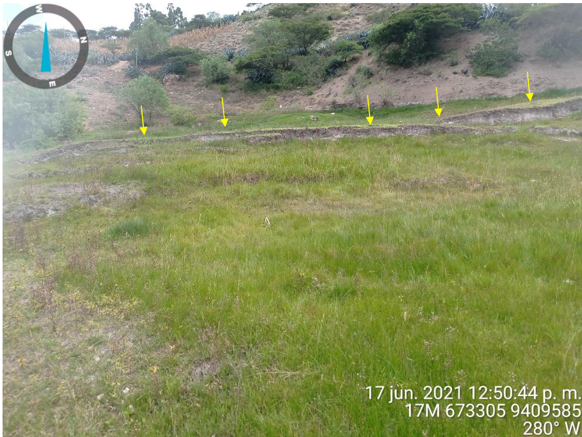
Figura 7: Ladera afectada por reptación de suelos en la cual se ha identificado grieta (debajo de flecha amarilla) en el suelo de 10 cm de salto en zonas saturadas por flujos de agua.
