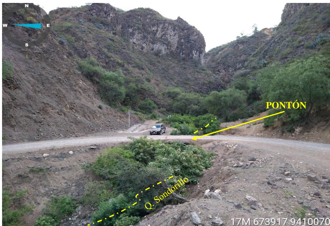
Figura 10: Cauce de la quebrada Sondorillo que fluye oeste a este, durante su recorrido se encuentra erosionando el pontón ubicado debajo de la vía Sondorillo - Huancabamba
