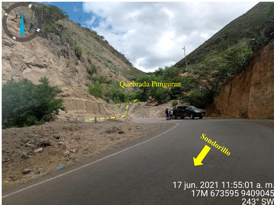
Figura 8: Cauce de la quebrada Pungurán. Los flujos de detritos podría afectar la vía asfaltada Sondorillo – Rumi Corral.
