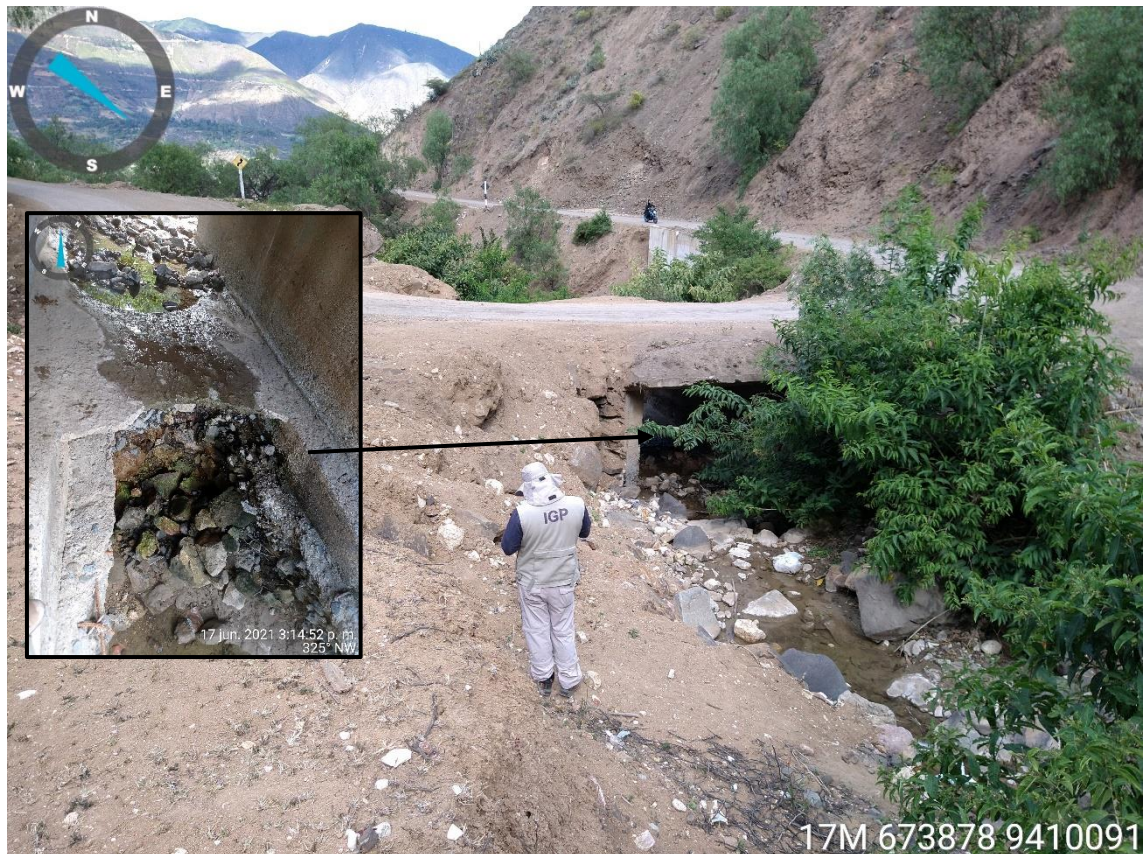
Figura 12: Pontón ubicado en la vía Sondorillo – Huancabamba que ha sido erosionada en el piso de dicha estructura
