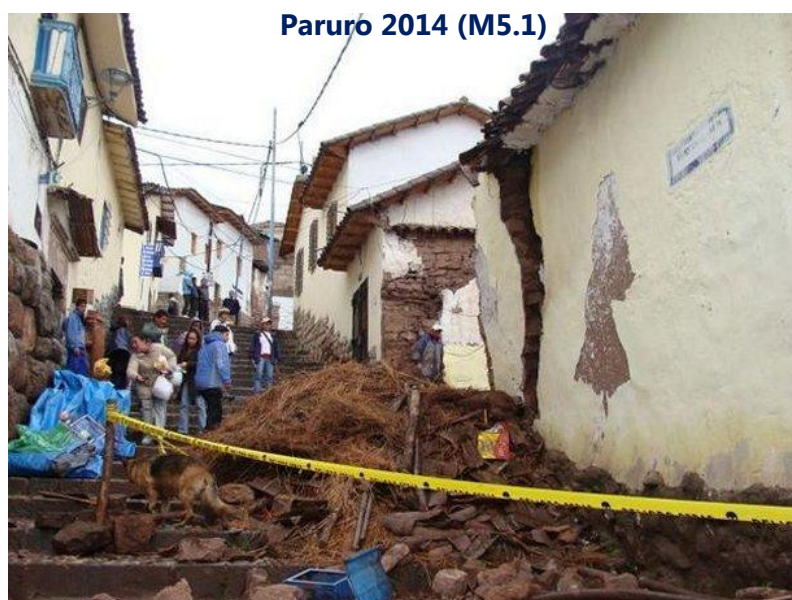
Figura 18: Escenarios de daños producidos por sismos ocurridos en las ciudades de Pisco en el 2007 (M8.0) y Paruro en el 2014 (M5.1). Obsérvese que las viviendas que han colapsado fueron construidas con materiales similares.
