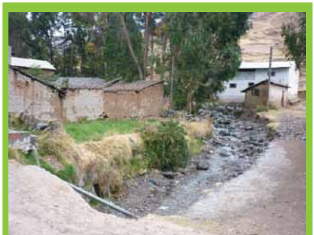
Figura 6. En la imagen se aprecia el cauce del río Negro sobre el cual discurrió el flujo de lodo acontecido en el mes de marzo del 2010 que afectó alrededor de 15 viviendas.
