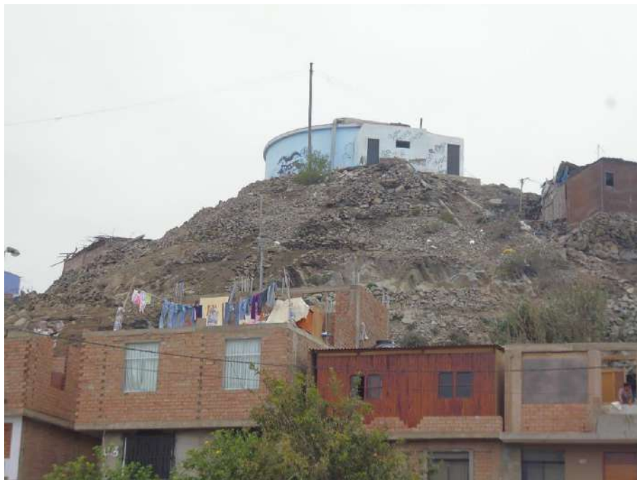
Figura 33: Zona de caída de rocas y detritos de origen antrópico generados por la presencia de un tanque de agua en la cima de la colina ubicada en el extremo norte de la ciudad de Mala..
