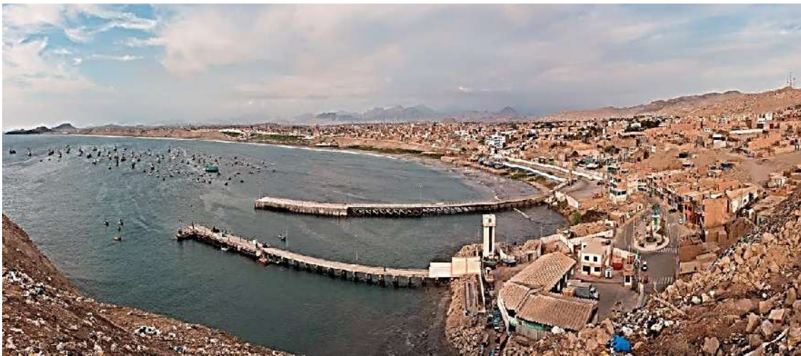
Figura 6: Vista panorámica de las zonas de playa de Huacho considerada en el modelado de tsunamis
