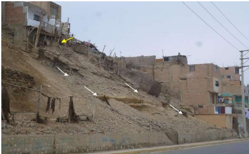
Figura 38: Zona de alta susceptibilidad a la ocurrencia de derrumbes (flechas en blanco). Las flechas de color amarillo indica la zona de apuntalamiento de viviendas.
