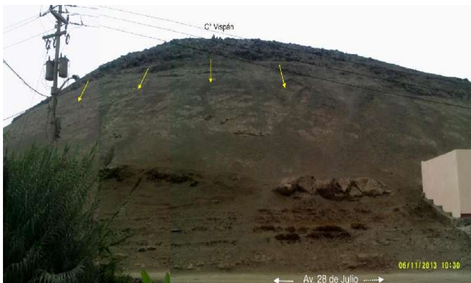
Figura 36: Rocas volcánicas que suprayacen a suelos sedimentarios conformando el cerro Vispán. Las flechas amarillas indican la dirección de caída de bloques inestables.
