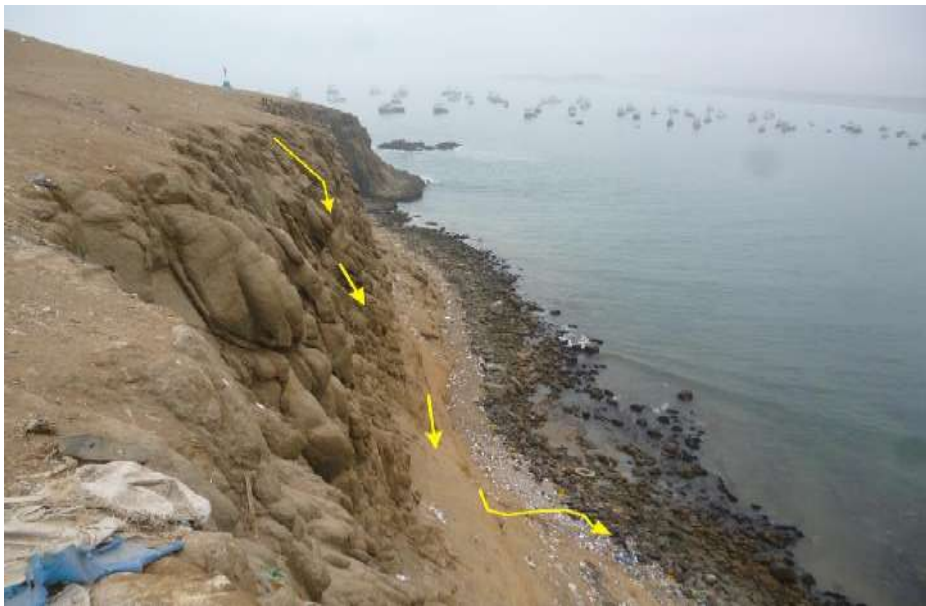
Figura 35: Bloques de piedras susceptibles a caer en los acantilados de Punta Viuda
