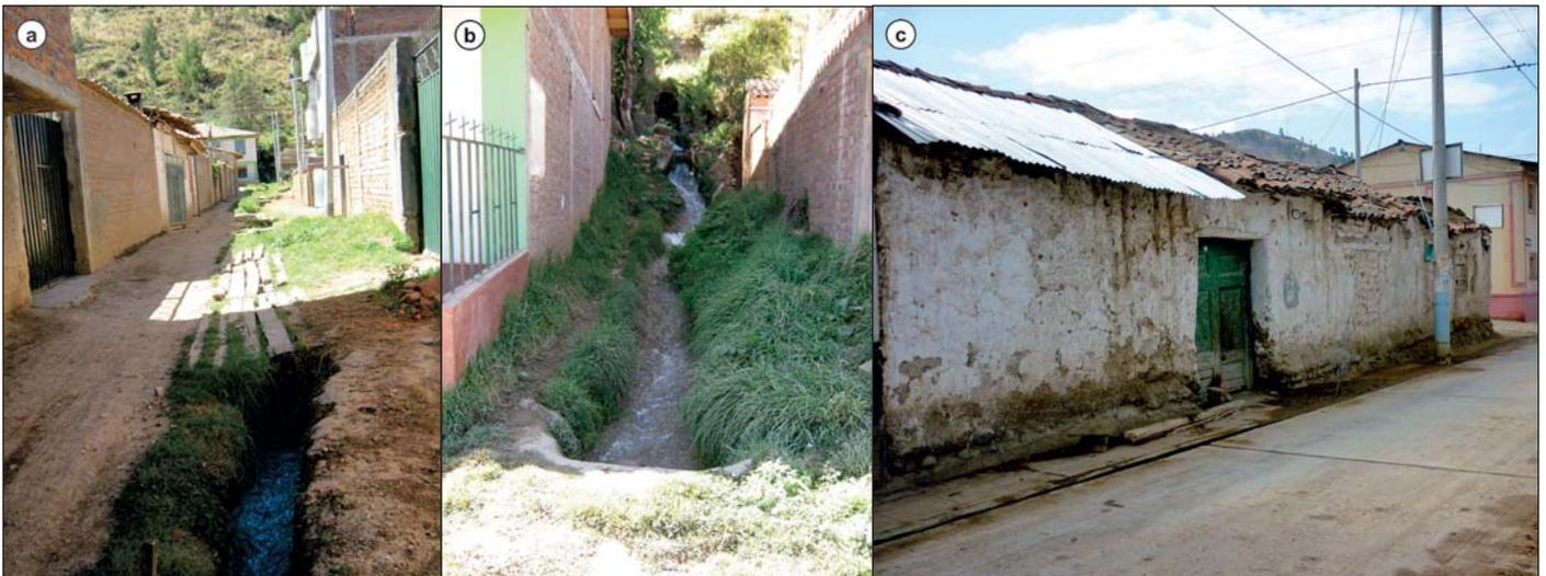
De izquierda a derecha: Foto 3.18 y 3.19 Se observa que la base de las edificaciones de las viviendas construidas se verán afectadas por la gran humedad que existe, por la existencia del canal de regadío, que se encuentra a 0.50 - 1.00 metros. Foto 3.20 Vivienda de adobe en pésimas condiciones de conservación, que se encuentra en riesgo de colapso por la antigüedad de su infraestructura. Créditos L. Céspedes.
