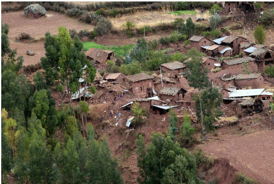
*Figura 8. Viviendas afectadas por el sismo de Paruro en la localidad de Misca. Obsérvese el tipo de material utilizado y la calidad de deterioro de las viviendas de adobe.*
