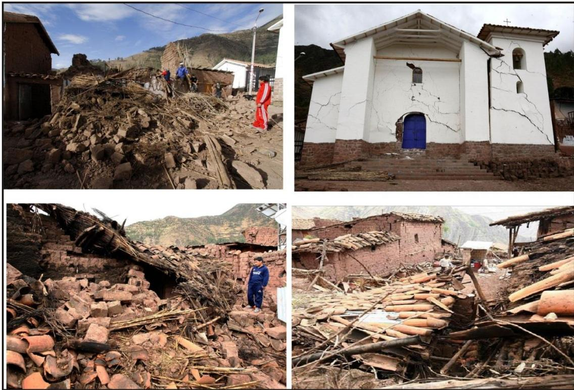
Figura 9. Viviendas afectadas por el sismo de Paruro. Obsérvese el tipo de material utilizado en zonas andinas como la localidad de Misca.
