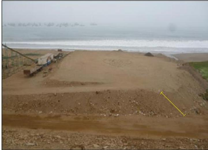
*Figura 6: Terraplén de 2 metros de espesor sobre el nivel natural del terreno.*
