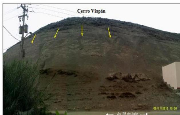
*Figura 13: Rocas volcánicas que suprayacen a suelos sedimentarios conformando el cerro Vispán. Las flechas amarillas indican la dirección de caída de bloques inestables.*
