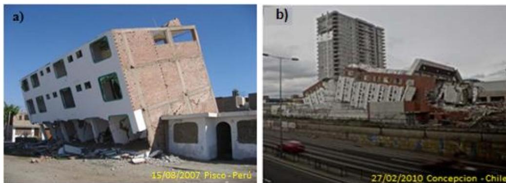
*Figura 26: a) Daños estructurales debido al desplazamiento de la losa de cimentación, b) Daños estructurales debido al desplazamiento de la cimentación en Concepción*
