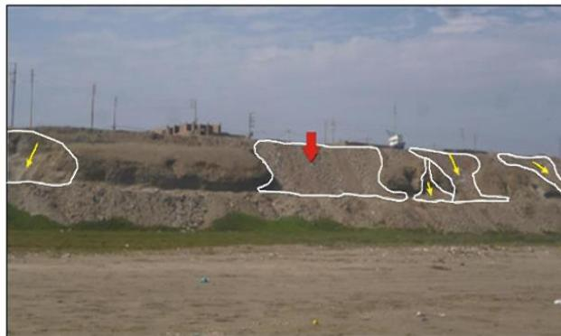
*Figura 14: Derrumbes en taludes conformados por depósitos aluviales. Ellos se encuentran en el límite de los distritos de Caleta Carquin y Huacho.*
