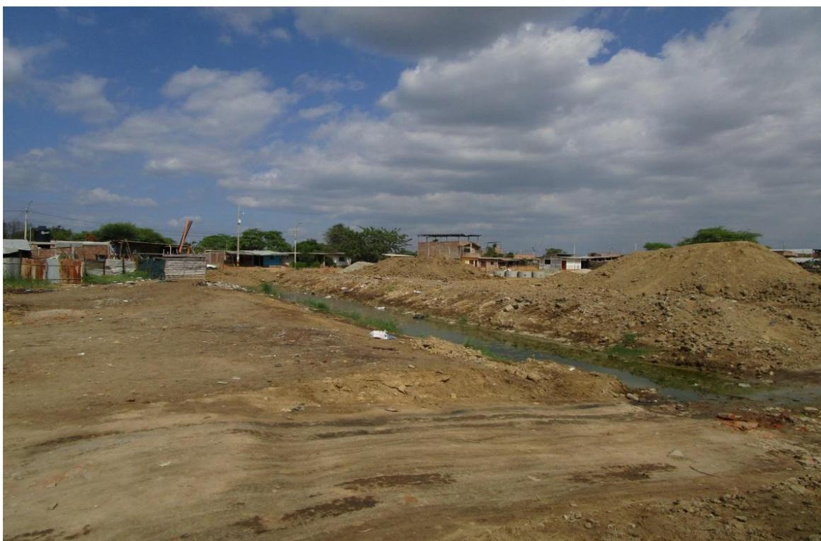
*Figura 21: Falta de mantenimiento del canal que pasa por el AA.HH. Renacer y que en época de precipitaciones colapsa e inunda a las viviendas aledañas al canal.*
