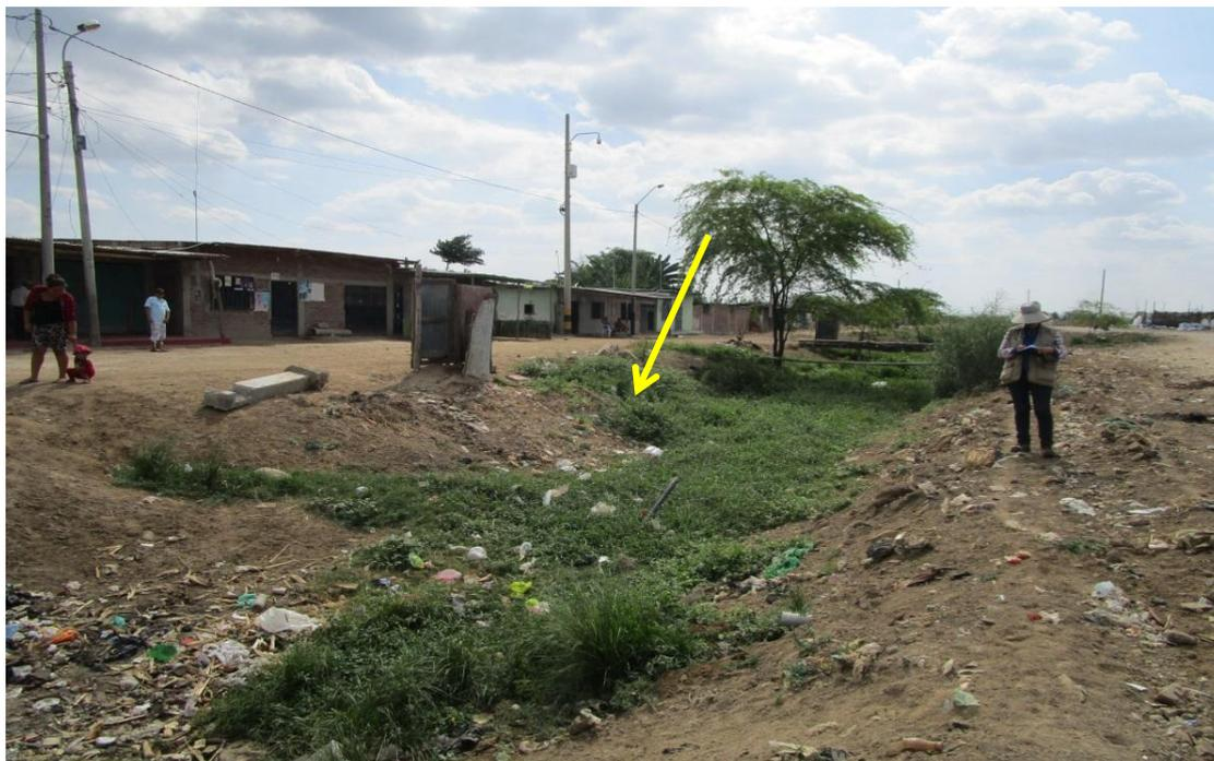
*Figura 22: La falta de mantenimiento del canal que pasa por el AA.HH. Ricardo Palma, impide el flujo de las aguas, lo que permite el desborde del canal afectando por inundación a las viviendas aledañas.*
