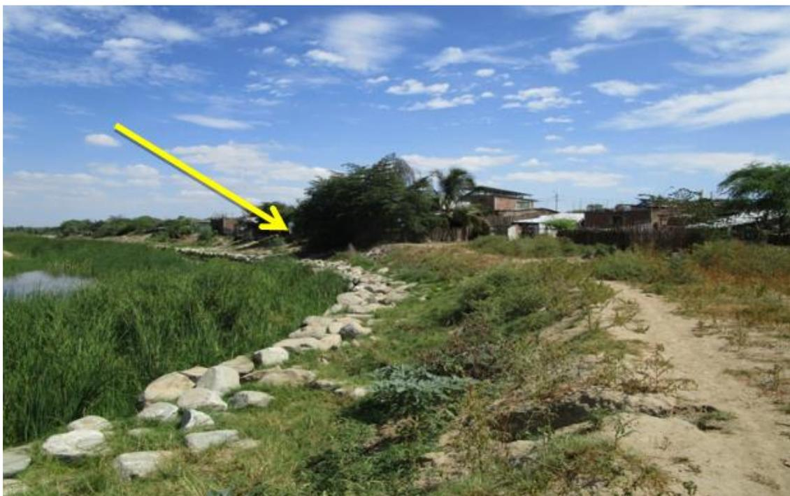
*Figura 16: Viviendas aledañas a la quebrada Carneros (flecha amarilla) afectadas por el desborde de la quebrada en mención. A pesar del enrocado existente, no es suficiente para controlar la erosión de las riveras de la quebrada.*
