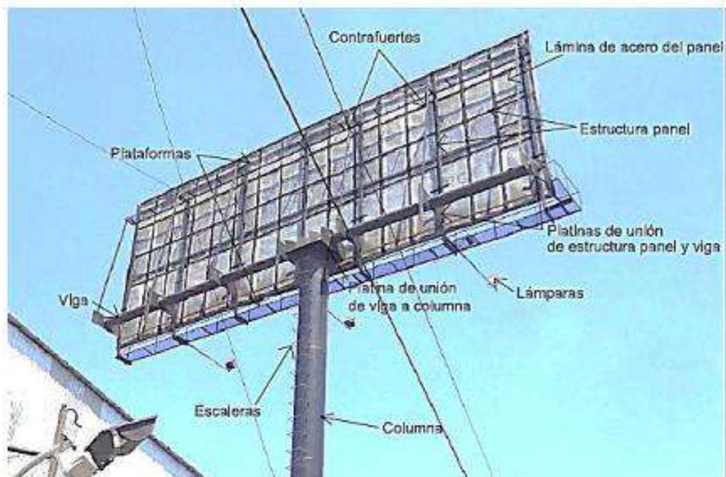
Figura N° 15. Esquema de un panel monumental. (Cuté, 2014)
