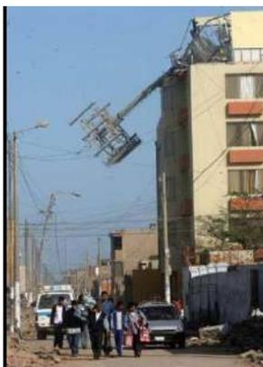
Figura N° 11. Estación Base ubicada en un sexto piso, quedando suspendida después del sismo de gran magnitud de Pisco (2007).
