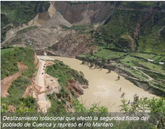
Deslizamiento rotacional que afectó la seguridad física del poblado de Cuenca y represó el río Mantaro.
